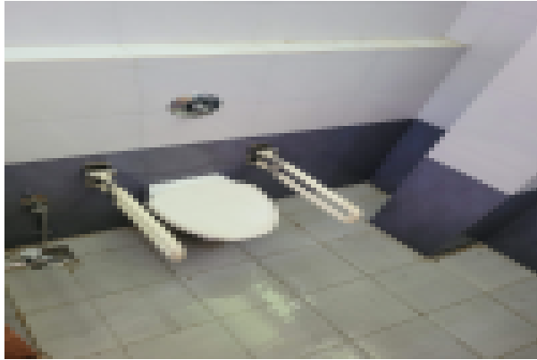
CWSN TOILET PHOTO
